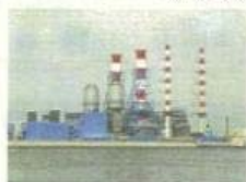
火力発電所建設
