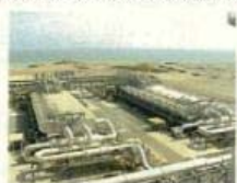
海水淡水化プラント建設
